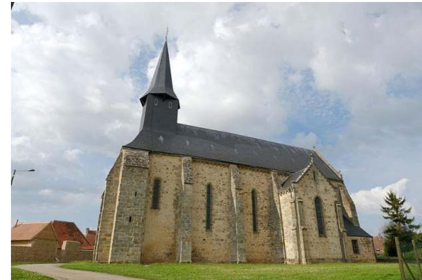
Figure 194 : Eglise Saint-Martin à Parnac (Source : Monumentum)
