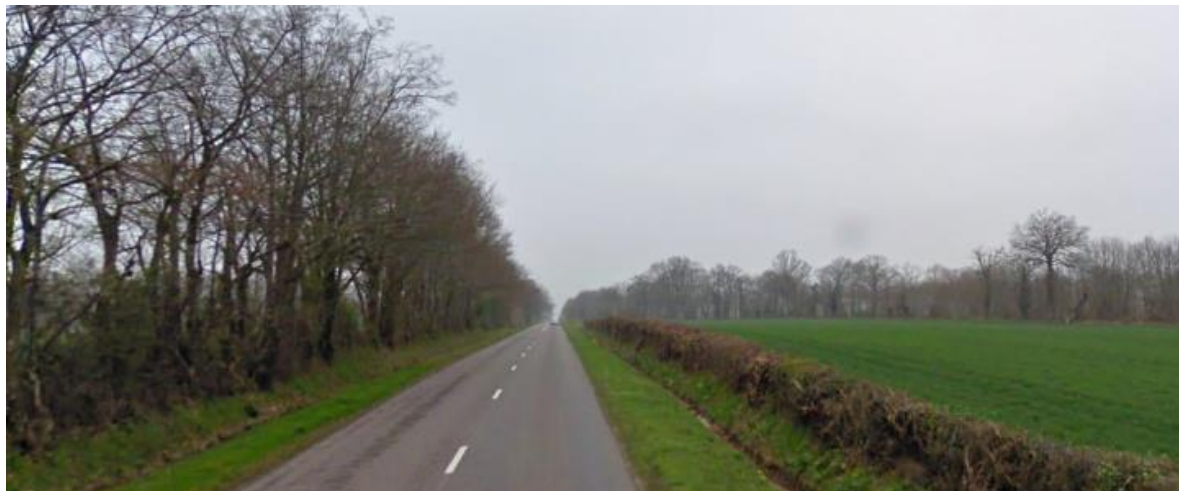
Figure 161 : Route départementale 1 (Source : Google)
